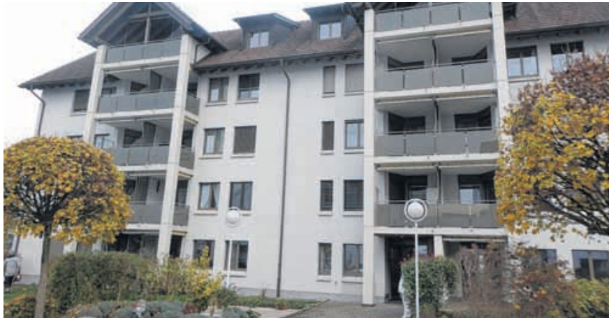
Die Sanierung des Hauses Pfarrmatte 3 ist abgeschlossen.
