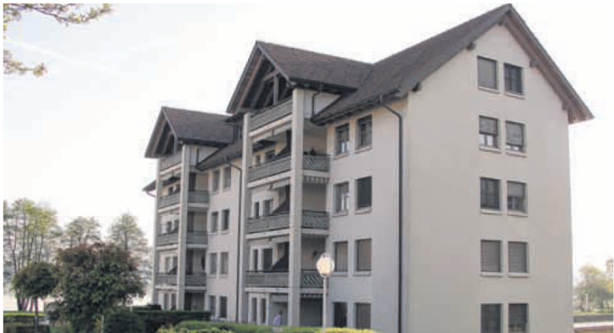
Die Pfarrmatte 3 soll saniert werden.
